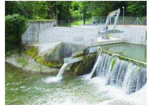
La nouvelle prise d'eau (en béton clair) à l'entrée du canal, avec la construction d'une passe à poissons.
